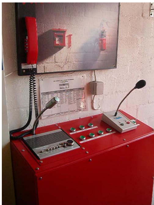
Das Schaltpult in der Fahrzeughalle mit Funkgerät und Voice-Recorder
